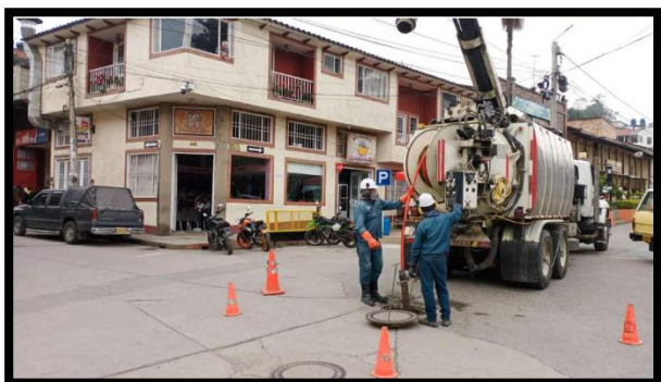
Limpieza y mantenimiento de las redes de alcantarillado.
