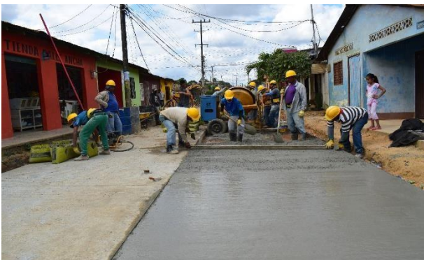
Pavimentación de calles
